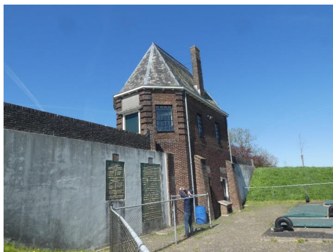
Nieuw elektrisch gemaal met twee plaquettes
