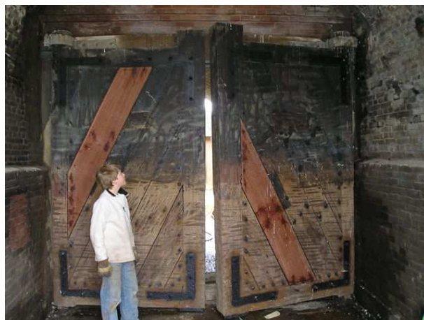
Foto van de puntdeuren in de sluis tijdens de restauratie in 2005
