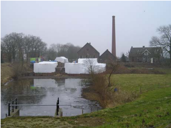
Sluiscomplex ingepakt om tijdens vorst door te kunnen werken.
