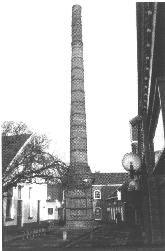
Afb. 5. De schoorsteen van de voormalige fabriek Schrader Schneider Tyert & Co te Delden staat nu als gedenkteken in een winkelstraat. Hoogte ongeveer 30 meter. Op de foto is te zien dat de schoorsteen in het verleden eens verhoogd is. Gebouwd rond 1920.
