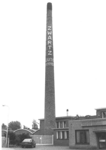
Afb. 9. De schoorsteen van de firma Zwartz te Oldenzaal: een voorbeeld van naoorlogse schoorsteenbouw (1949), strak en zonder versiering in het metselwerk, behalve de naam 'Zwartz' in witte letters. De schoorsteen wordt in augustus 1993 gesloopt, het bedrijf bestaat echter nog steeds.
