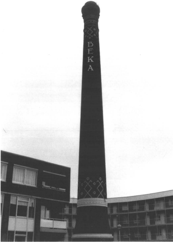
Afb. 15. De monumentale schoorsteen van Van de Berg en Krabbendam, Be-ka, te Tilburg, gebouwd door Canoy Herfkens in 1904, hoogte 50 meter.
