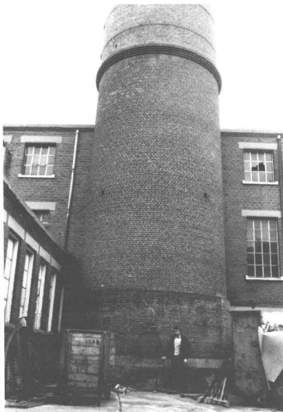
Afb. 13. De voet van de grootste door De Ridder gebouwde schoorsteen, voor Ter Horst te Rijssen. Deze in 1923/24 gebouwde schoorsteen had een hoogte van 65 meter. Hij werd gesloopt in 1993.
