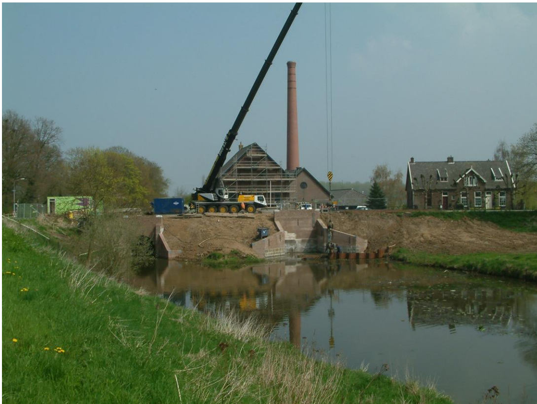
Links de uitstroom van pomp 2. Rechts die van pomp 1. Voor het stoomweekend zal de damwand van de noordersluis getrokken worden. Na het stoomweekend zal de damwand van de zuidersluis getrokken worden.
