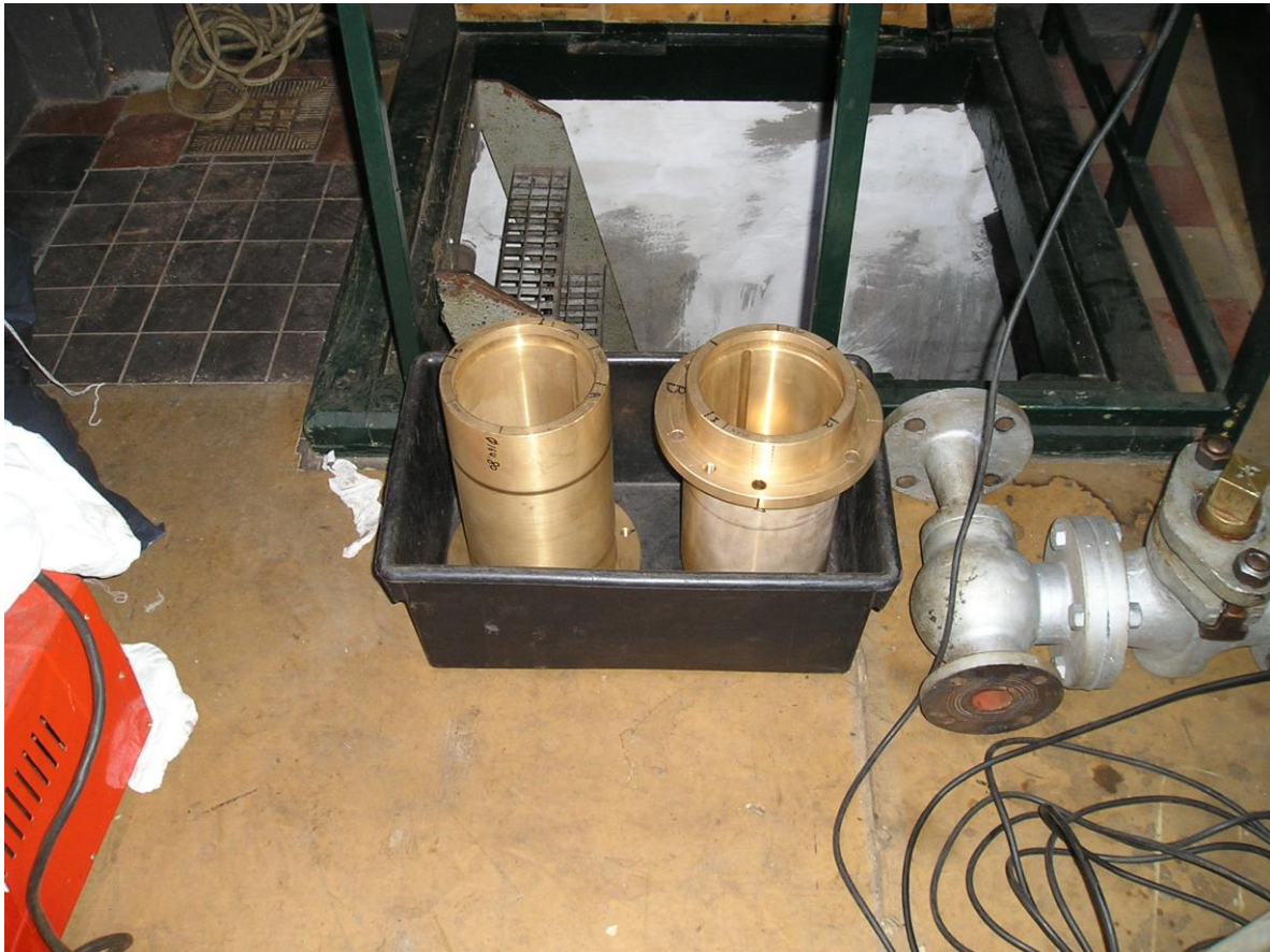
Nieuwe asbussen van de bemalingspomp
