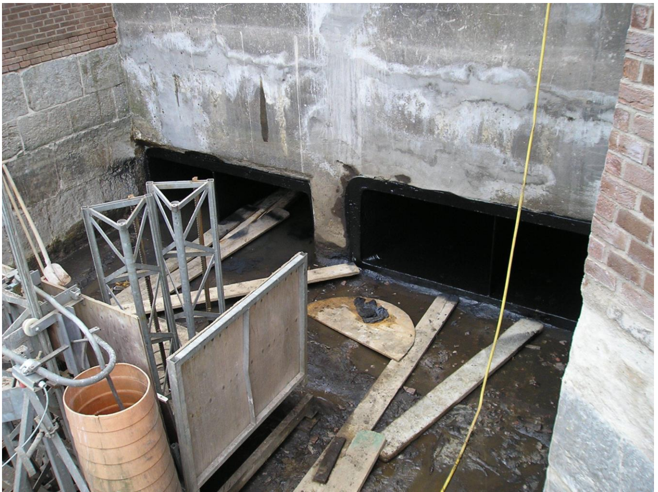
Links de uitstroom van pomp 2. Rechts die van pomp 1. Voor het stoomweekend zal de damwand van de noordersluis getrokken worden. Na het stoomweekend zal de damwand van de zuidersluis getrokken worden.
